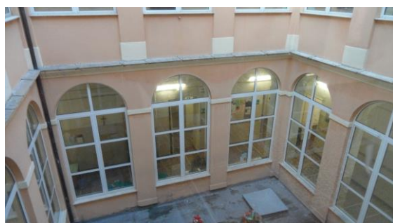
Figura 4.9 – Serramenti in pvc e vetrocamera – scuola elementare – corte interna
