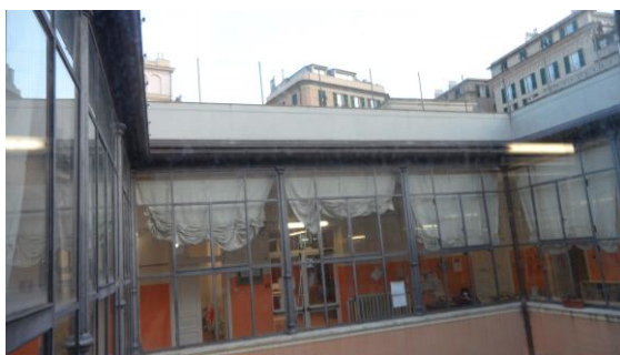
Figura 4.11 – Serramenti in metallo e vetro singolo – scuola materna
