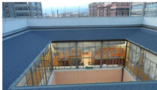
Figura 8.4 – Infissi esistenti – piano terzo corte interna
