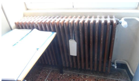
Figura 4.14 – Particolare – radiatore in ghisa – scuola elementare
